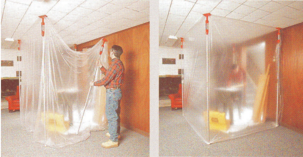
Teilraumabtrennung mit »Zipwall«.
