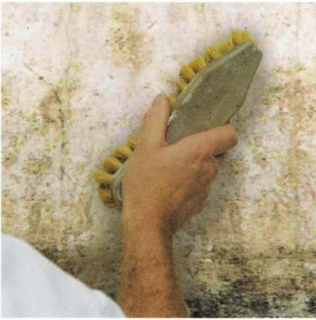
Ein fachgerechtes Entfernen von vorhandenem Schimmelfall ist eine der wesentlichen Voraussetzungen bei der Sanierung.
